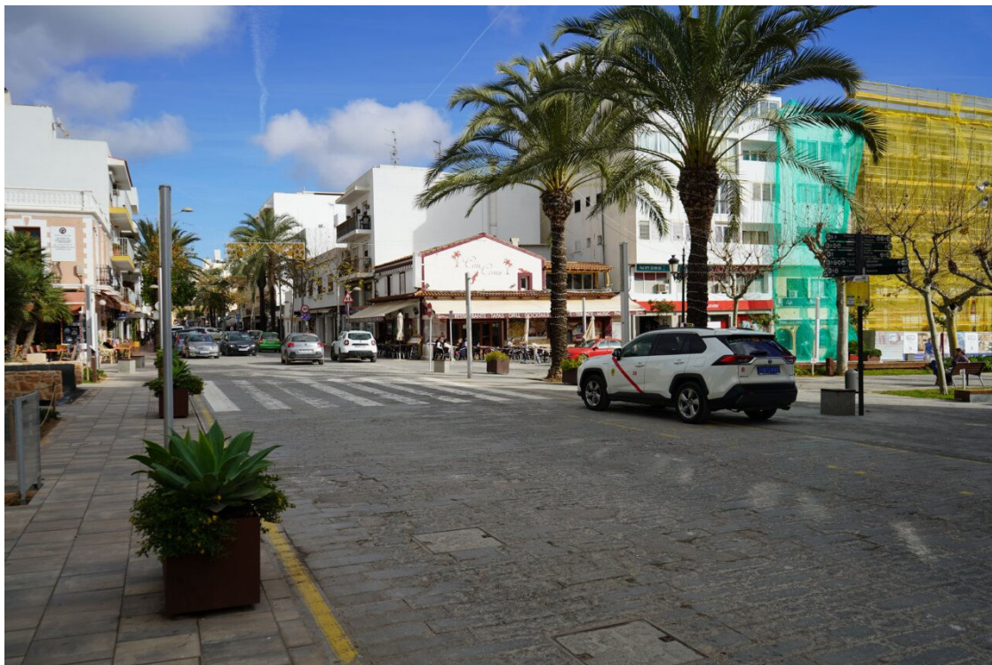
Renovación pavimento calle Sant Jaume
