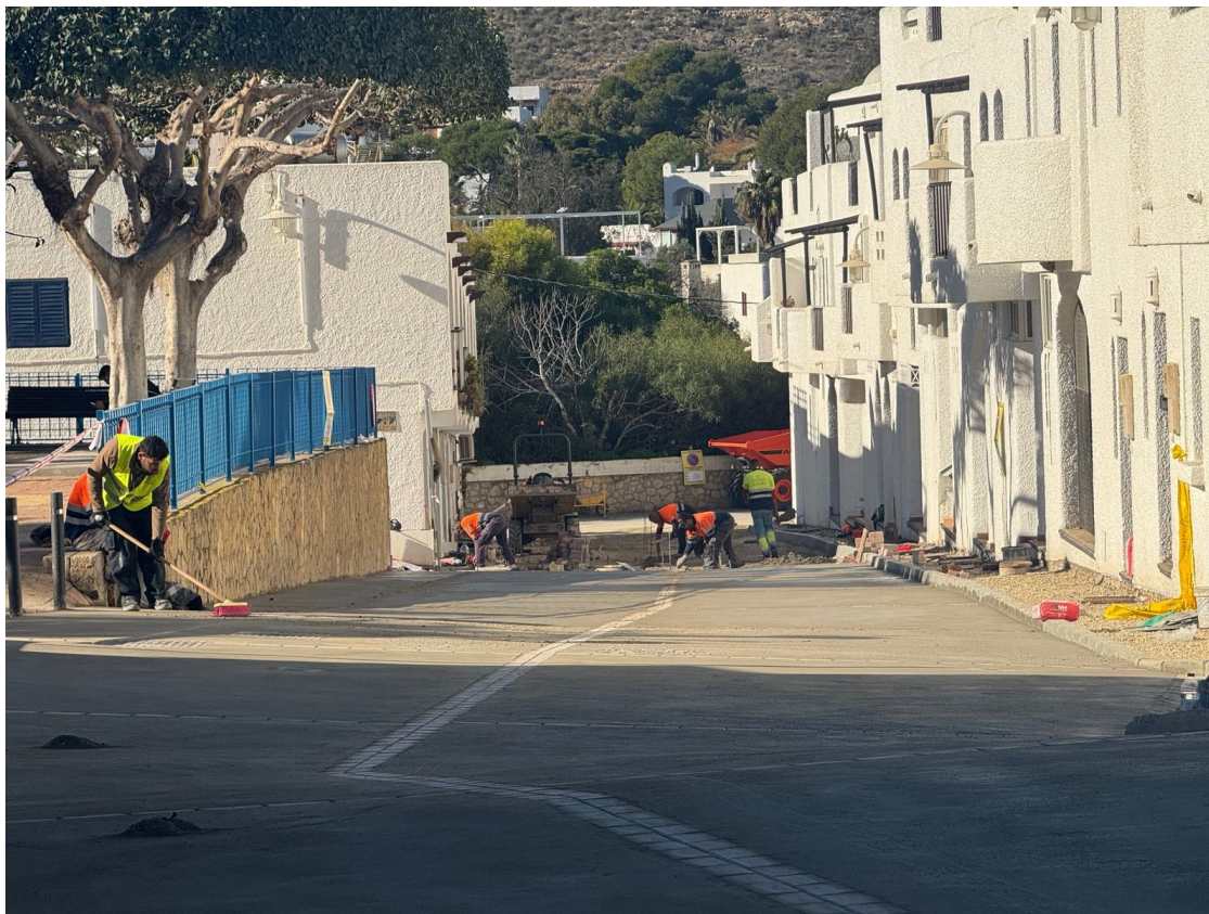
Obras en calles de Agua Amarga.
